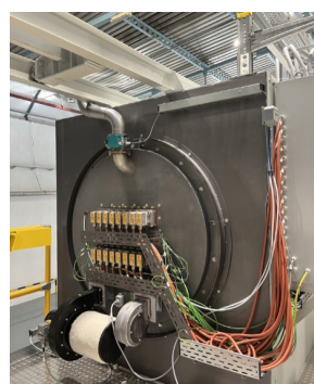
Slika 2 - Električna peć (lijevo), TAB s električnim grijačima (desno)
